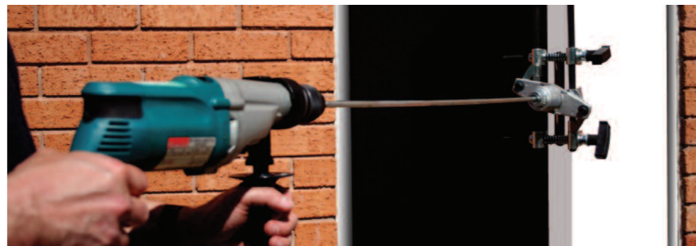
Gehäuse mit Langbohrführung
